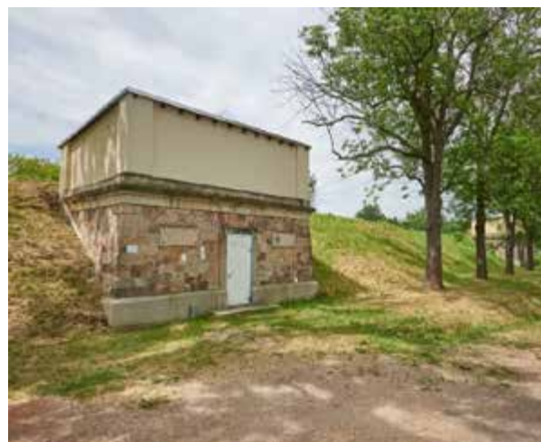
Bild: 52 Trinkwasserbehälter wie dieser sind Bestandteil unserer Trinkwasserversorgung. Quelle: Wasserwerke Zwickau GmbH - Foto-Atelier Lorenz
