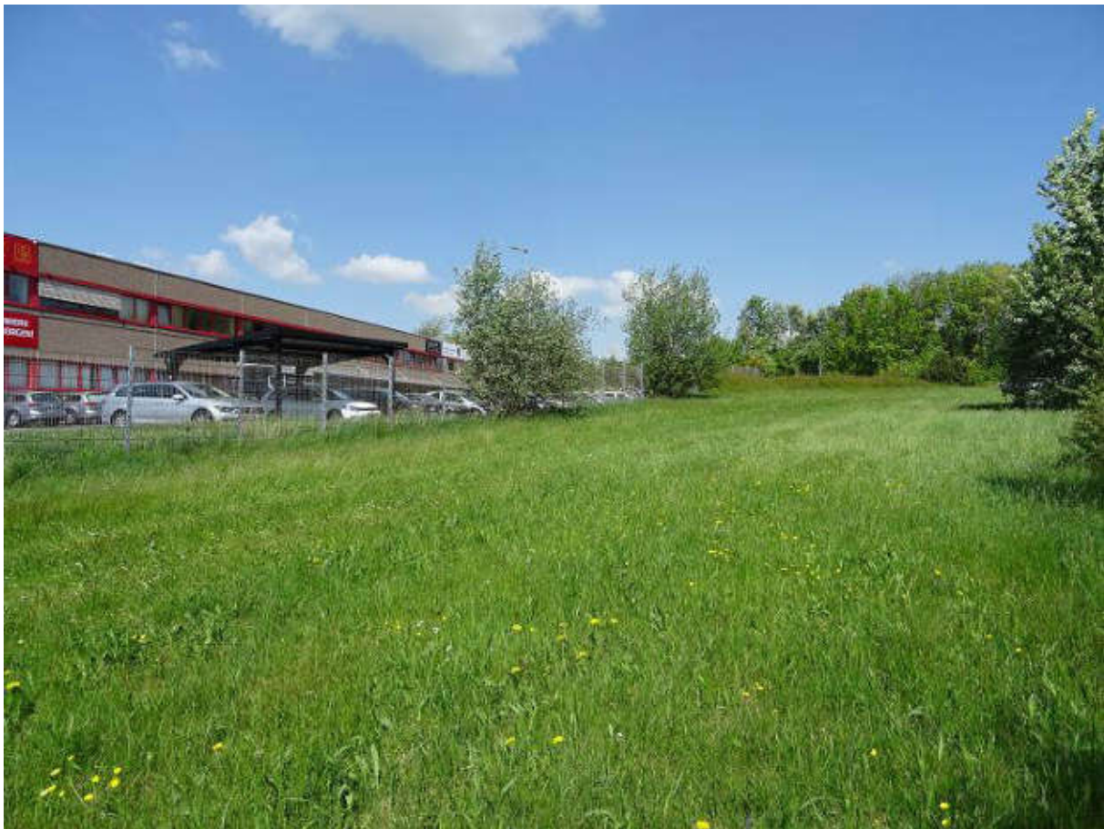
Foto 20: Blick von Süd auf den geplanten Anbau-/Erweiterungsbereich mit Werkhalle, 11.05.2022.
