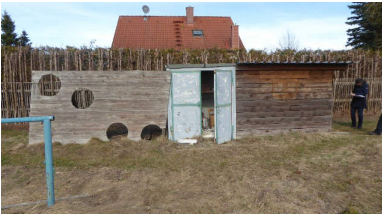
Foto 6: Geräte- und Ballschuppen waren offen und wurden begangen sowie von außen untersucht – keine Hinweise auf Besiedlung, 07.03.2019.
