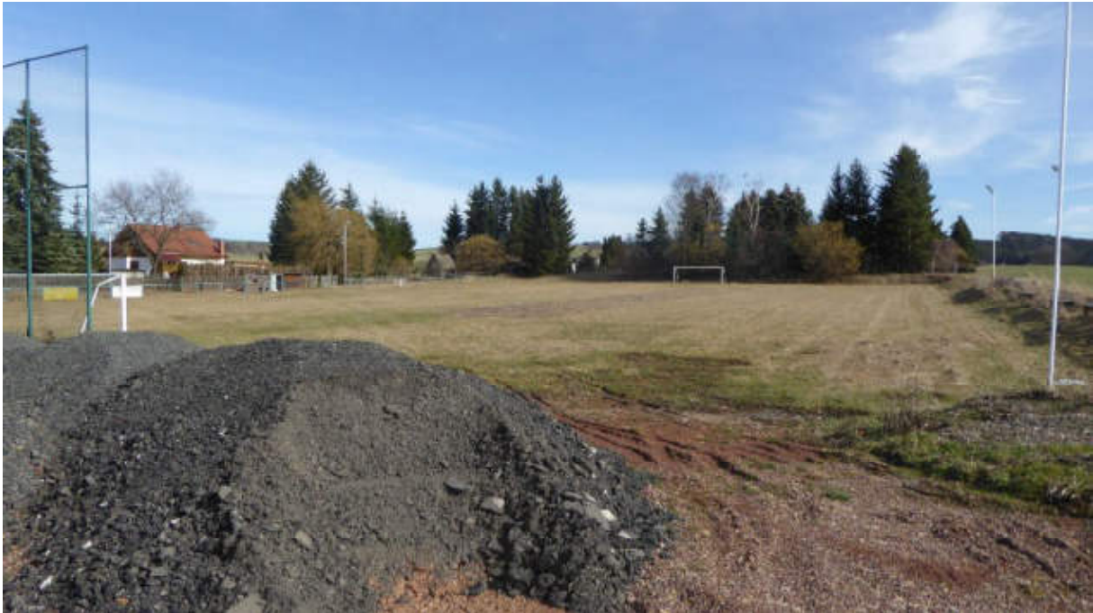
Foto 1: Blick von der Lichtensteiner Straße über die Zufahrt (Vereinsheim bereits abgerissen) auf den Sportplatz, 07.03.2019.
