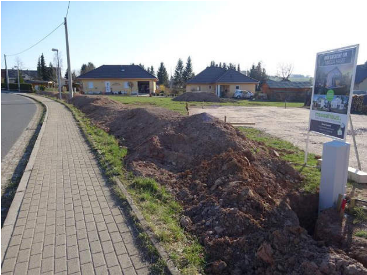
Foto 3: Lichtensteiner Str. im Übergang zum westl. Teil des Plangebiets mit Blick nach Süd, 25.03.20.
